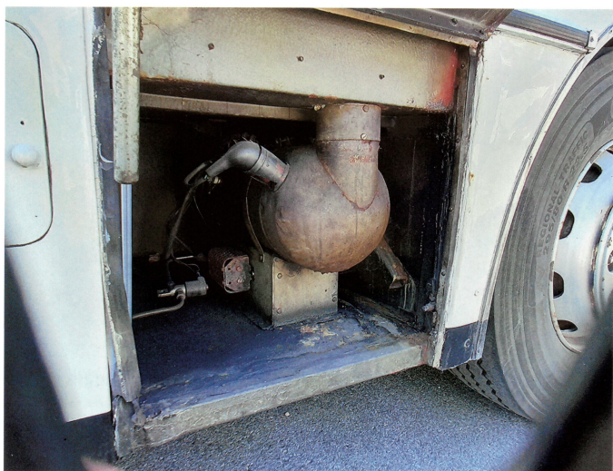
Zu sehen ist hier die Innenraumheizung.
